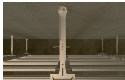
Abgehängte Decke mit Noniushänger
